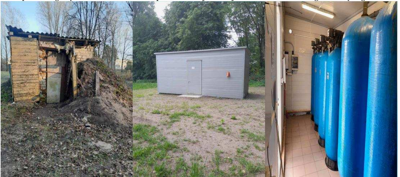
9 pav. Šilgalių k. vandenvietės namelis prieš investicija ir naujas namelis bei vandens gerinimo įrenginiai
